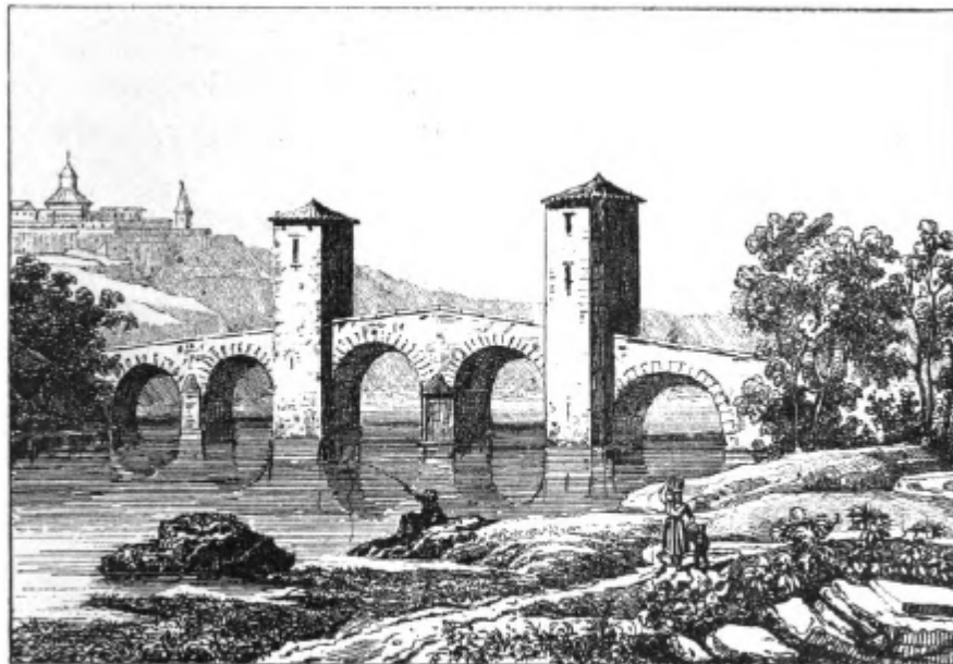
Pont de l'Arzobispo.
